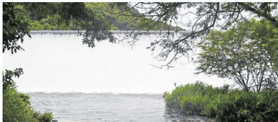
Após comportas serem danificadas, água verte por sobre a Barragem de Laranjeiras
