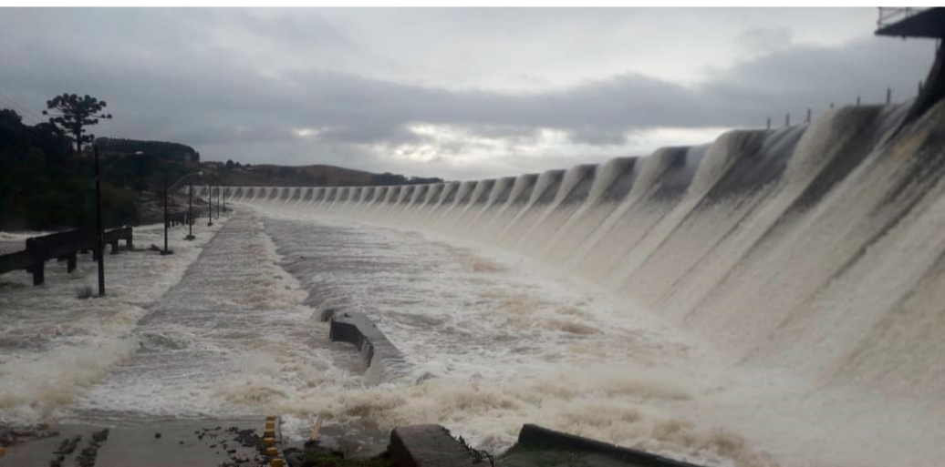
Barragem do Salto, na manhã de quarta (8)
