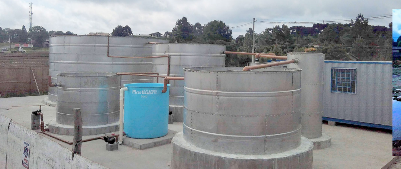
ETE Miná está em fase final de construção
