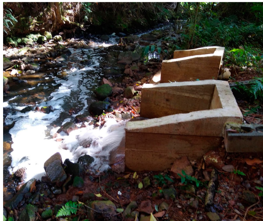
Esgoto em natura jogado no arroio
