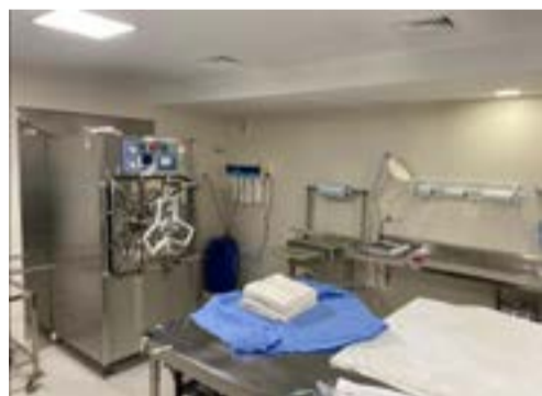
Novo CME – Centro de Materiais e Esterilização
