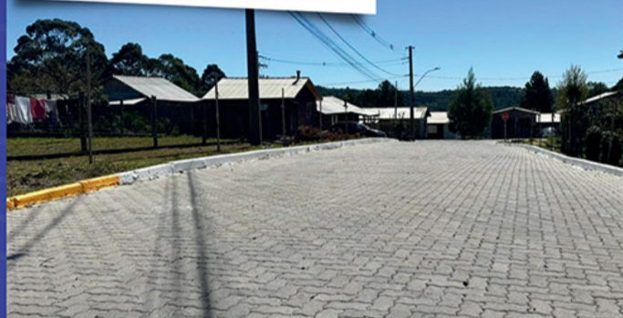
Pavimentações de ruas
