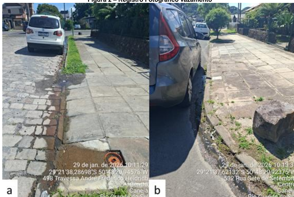
Figura 2 – Registro Fotográfico vazamento
